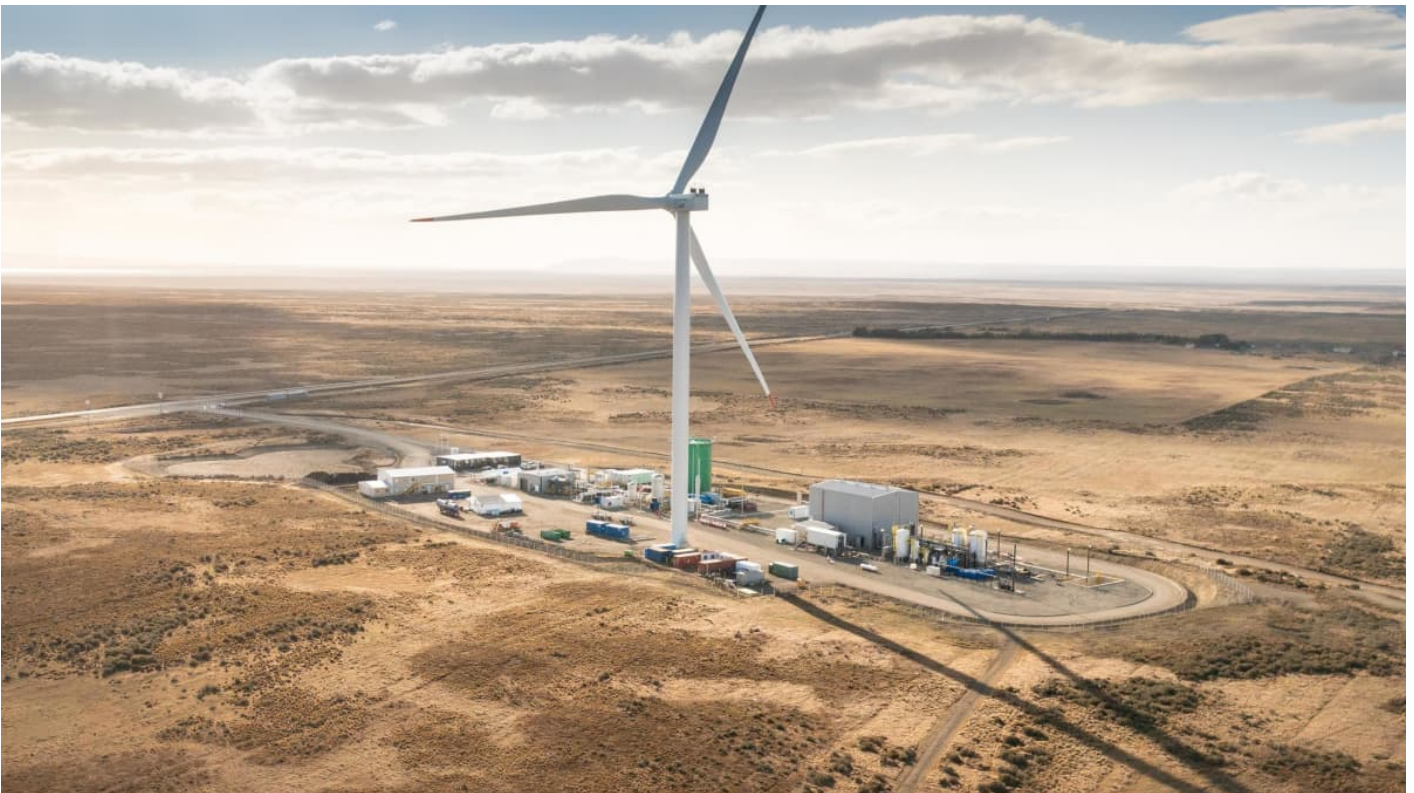
Die Siemens-Pilotanlage in Chile • © Porsche
